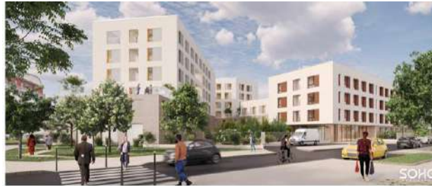
Site de reconstruction de l'Ehpad, du SMR
