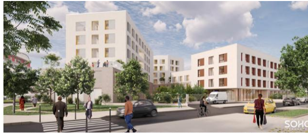
Site de reconstruction de l'Ehpad, du SMR
